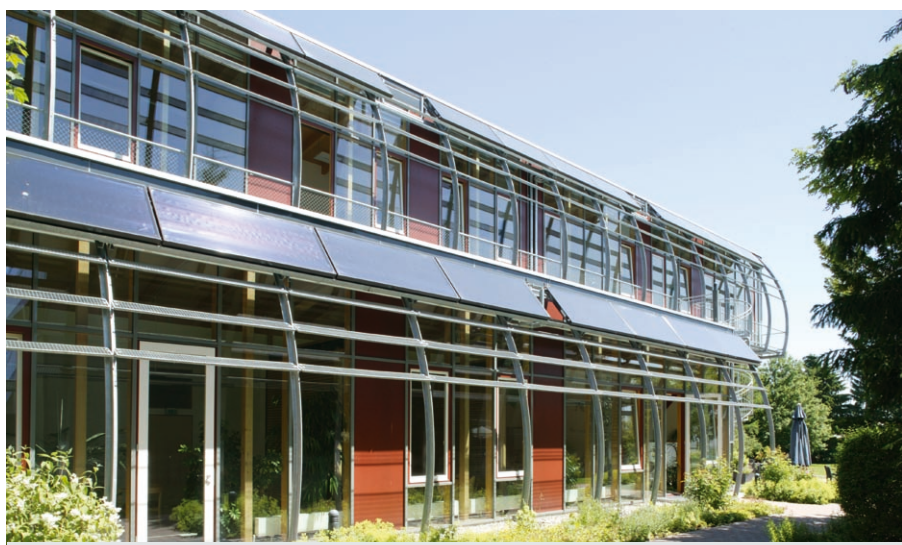
1. Panele fotowoltaiczne wkomponowane w elewację budynku
