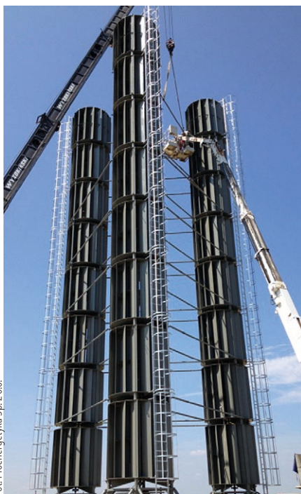
4. Pionowe siłownie wiatrowe Piskorza – elektrownie w systemie modułowym. Polski wynalazek i produkcja
